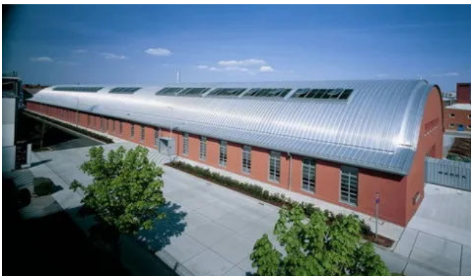
Zollinger Halle, Kalzip-Dach mit Glasoberlichtern
