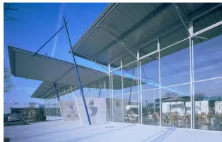
Glasfassade als Pfostenriegelkonstruktion
