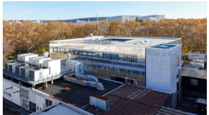
Reinraumfabrik Vishay FAB, Heilbronn
