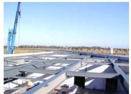
ca. 1.000 t Stahlbau für Montagehallen
