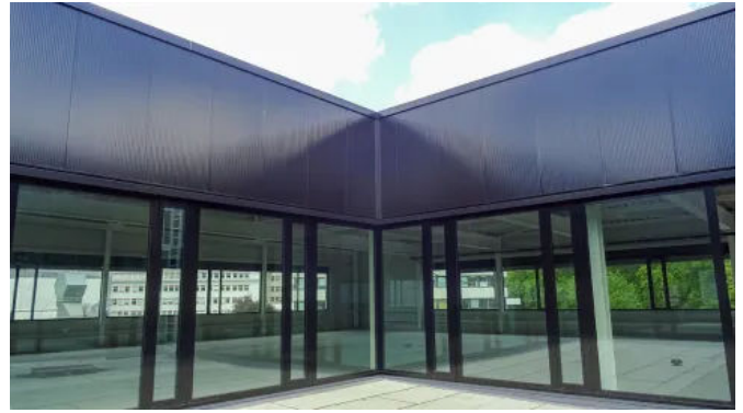
Reinraumfabrik Vishay FAB, Heilbronn
