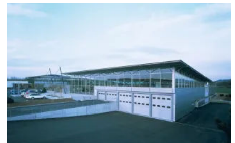
Kassettenwand mit Schuppenfassade, Dacheindeckung mit Foliendach
