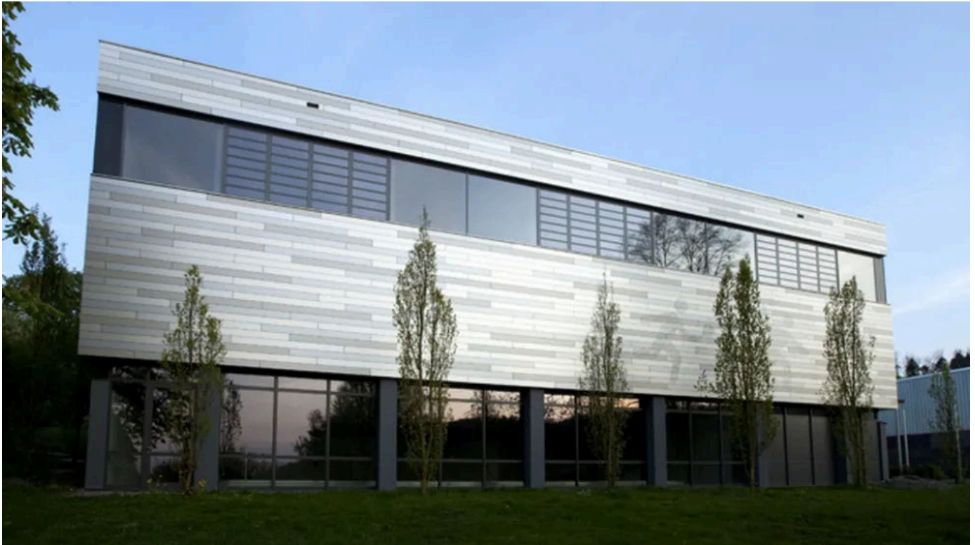
Turnhalle Nagold, Planung: Bonasera Architekten Nagold
