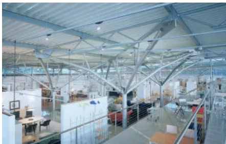
Stahlbau als Baumkonstruktion, beschichtet, 280 to
