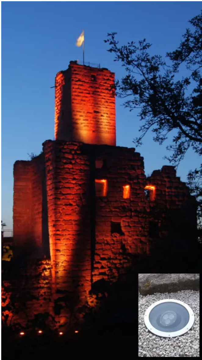
Burgruine Hiltpoltstein Akzentbeleuchtung. Foto: LMT
