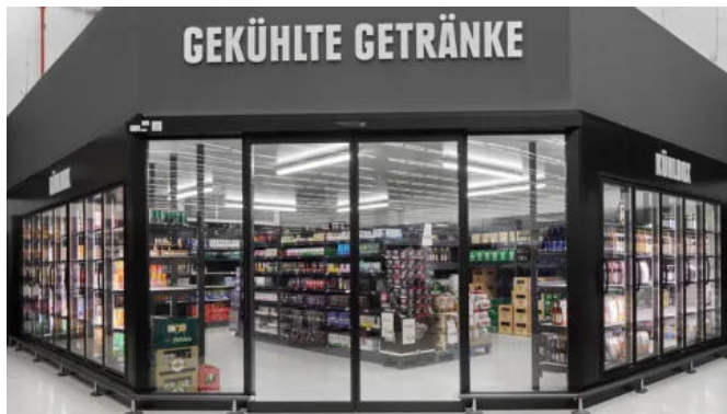
Glaskühlraum im E-Center Kohler in Freiburg-Zähringen
