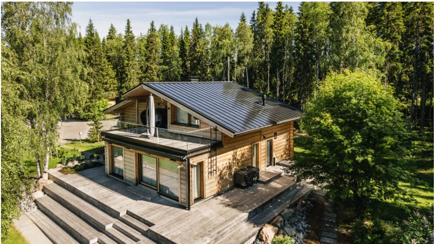
Land: Finnland, Ort: Pello, Objekt: Wohnhaus. Installation: 2024; Leistung: 12,71 kWp
