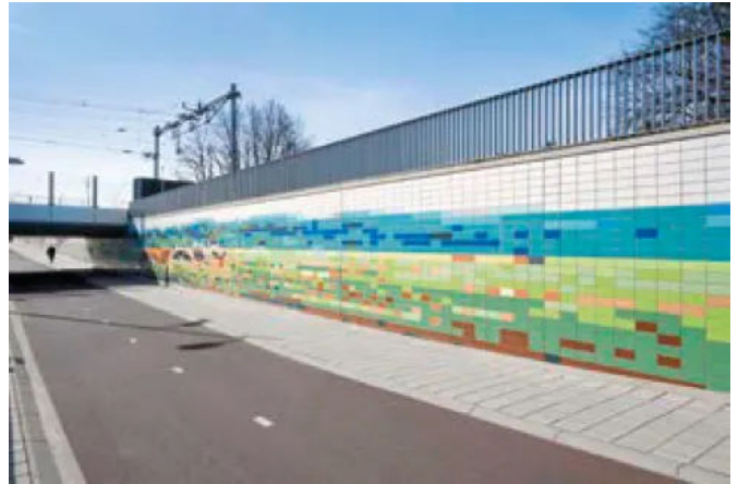
Fedor van Kregtentunnel, Niederlande /Foto: Marcel van der Burg
