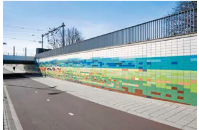
Fedor van Kregtentunnel, Niederlande /Foto: Marcel van der Burg
