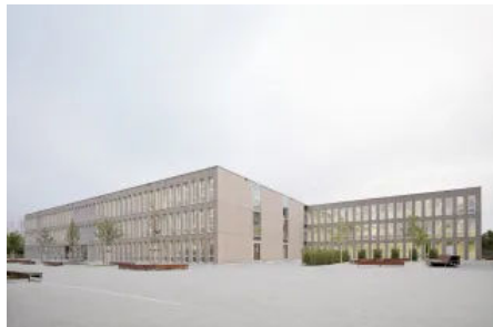
Realisiert als Holzmodulbau mit SupraFloor® Hybriddecken: Gymnasium Nord Frankfurt
