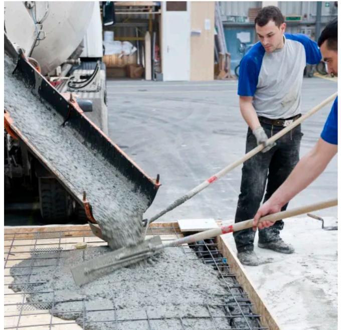
Die Hybridlösung kombiniert Holz und Beton zu einem optimierten Tragelement. Mit dieser Holz-Beton-Verbundbauweise lassen sich hohe Schall- und Brandschutzanforderungen problemlos erfüllen.
