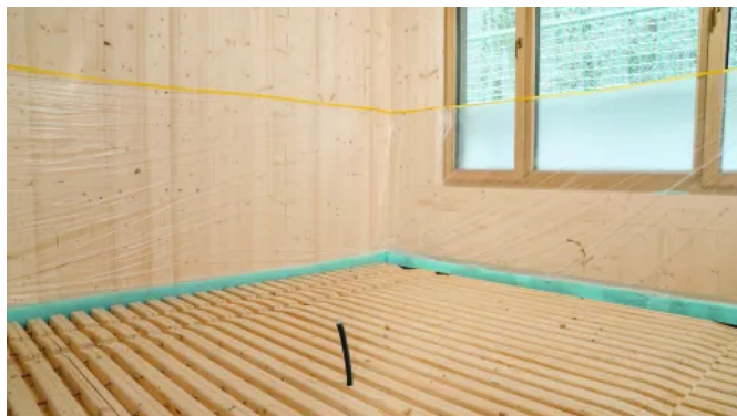
Deckenkonstruktion aus Massivholzfertigteilen | (© Nicole Aigner Videografie)
