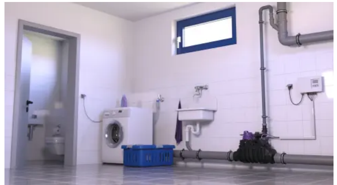
Ecolift Rückstauhebeanlage in eine freiliegende Abwasserleitung eingebaut
