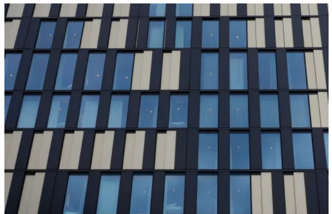
HUECK Trigon FS am QO Hotel Amsterdam - LEED Platin Zertifizierung(U.S. Green Building Council)
