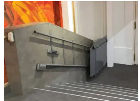
sani-trans Plattformlifte lassen sich standardmäßig elektrisch zusammenklappen.
