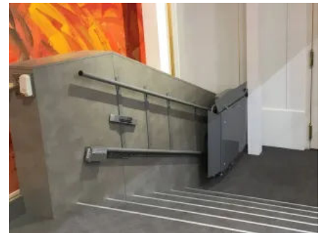
sani-trans Plattformlifte lassen sich standardmäßig elektrisch zusammenklappen.
