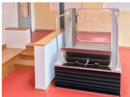
Die automatisch auf-/und ab fahrende Klapprampe ist zugleich Abrollssicherung.
