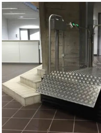
Die Rampe aus Edelstahl ist zugleich Abrollschutz für Rollstühle.
