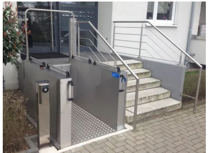
Hublifte können innen wie außen montiert werden.
