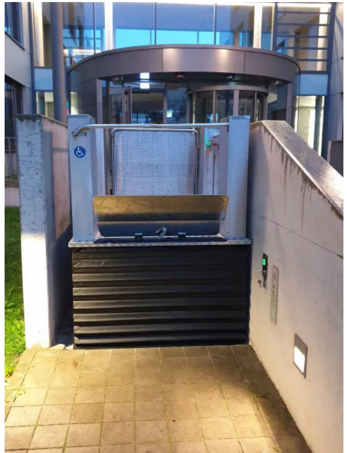
Die Antriebssäulen des MB Quattro erzielen eine Tragkraft von 500 kg.
