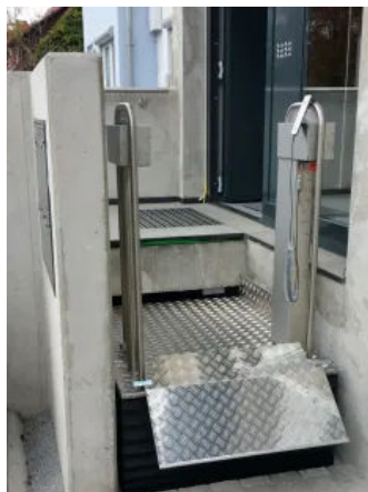
Standardbedienung über Handbedienteil mit Auf-/Ab-Taster.
