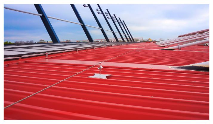
Horizontales Edelstahl-Seilsicherungsystem zur Absturzsicherung mit allgemeiner bauaufsichtlicher Zulassung (Z-14.9-789), geprüft und zertifiziert nach DIN EN 795 Anschlageinrichtungen. Durch die kontinuierliche Absturzsicherung gewährleistet das System höchste Sicherheit bei Arbeiten im absturzgefährdeten Bereich.
