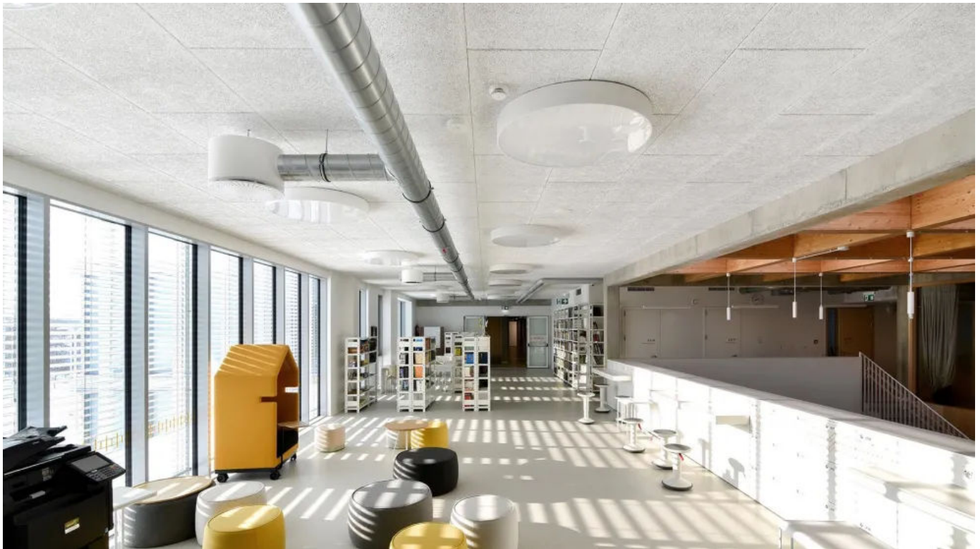
CEWOOD Akustikplatten mit Schraubmontage an Deckenkonstruktion
