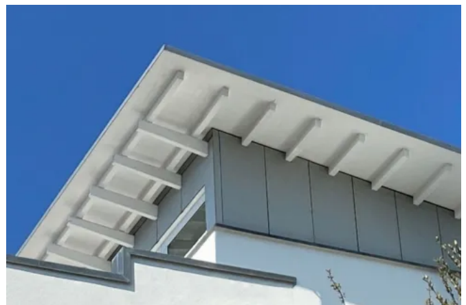
Dachüberstand mit „vita grundiert“ im geschützten Außenbereich
