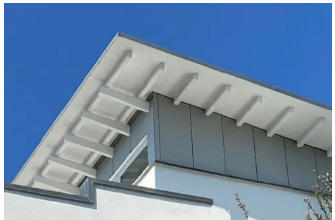
Dachüberstand mit „vita grundiert“ im geschützten Aussenbereich
