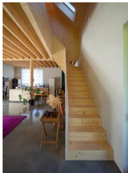
Auch für große Wandflächen mit hohen Decken ist der Lehmputz auf esb-Holzbauplatten geeignet.
