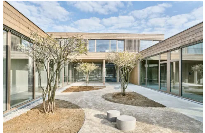
Konstruktiver Holzbau (© Eder Holzbau GmbH, Bad Feilnbach)
