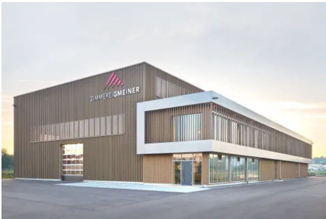
Hallenbau Zimmerei Gmeiner - LIGNA® systems (© Franziska Laub)
