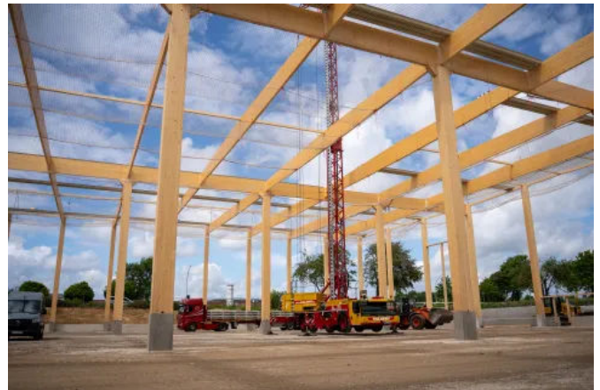
Effiziente Systembauweise mit speziell entwickelte Hybridstützen
