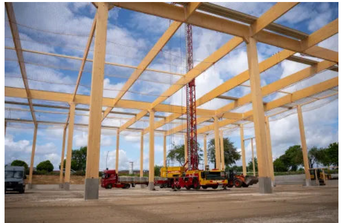
Effiziente Systembauweise mit speziell entwickelte Hybridstützen
