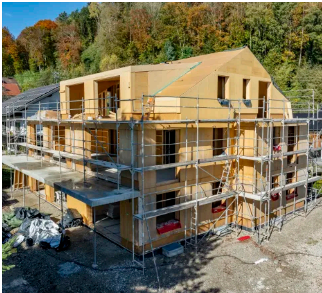
Mehrfamilienhaus in Hybridbauweise mit Holzmodulen von L-systems
