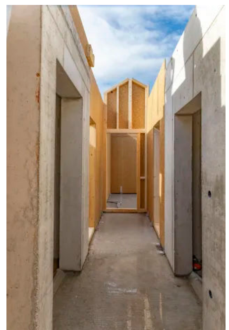
Hybridbauweise mit Holzrahmenbauelementen und Beton
