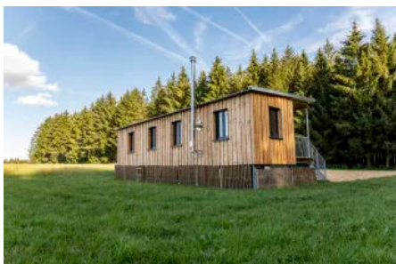
Die Stahlkonstruktion als Unterbau lässt sich als Stauraum nutzen und macht den Kindergarten zudem mobil.
