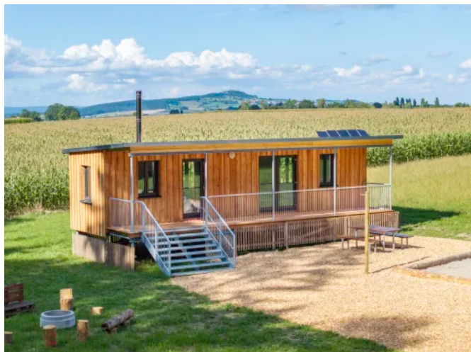
Der neue Waldkindergarten der Gemeinde Dürmentingen - eine Komplettlösung von L-systems.
