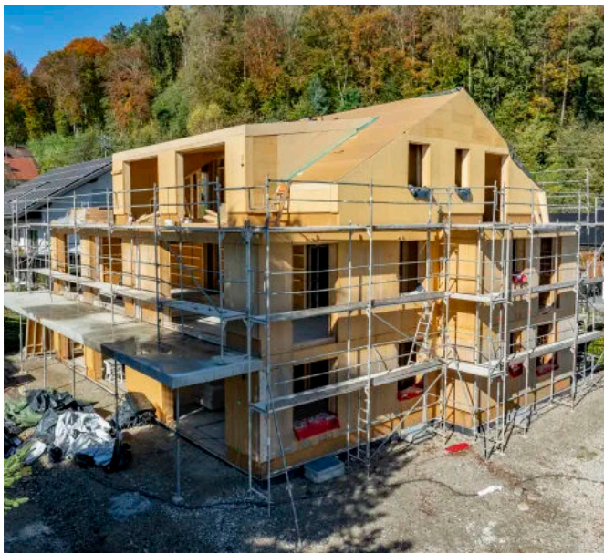
Mehrfamilienhaus in Hybridbauweise mit Holzmodulen von L-systems
