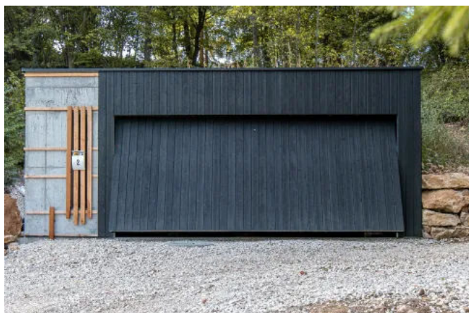
Referenzobjekt "SUYAKI | REGENSBURG GARAGE"
