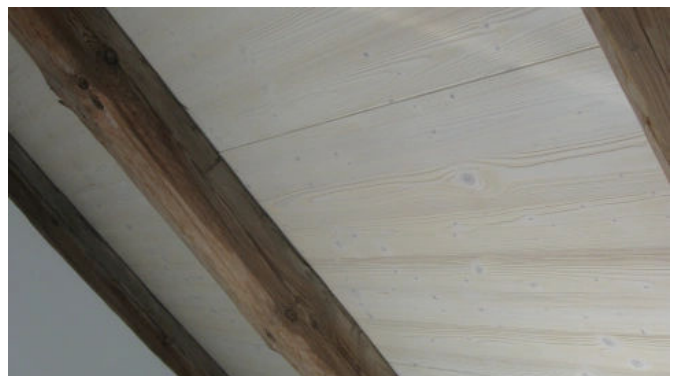
3 - Schicht-Verlegeplatte innen
