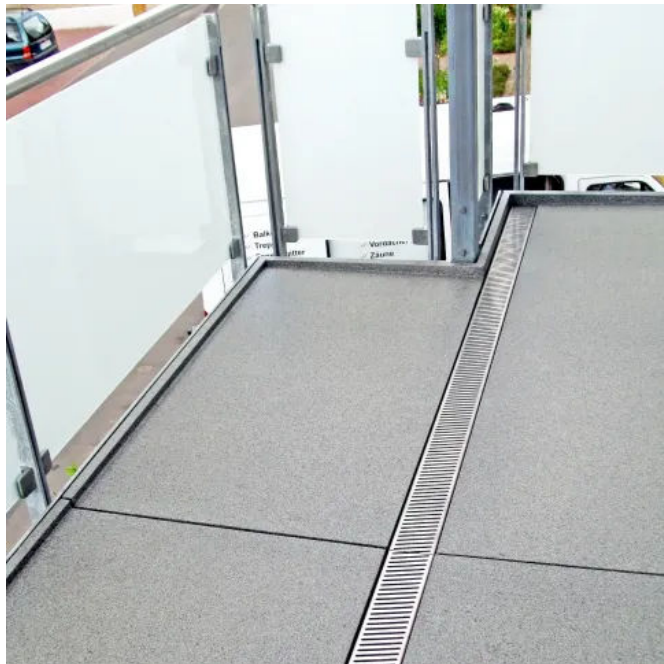
Bakodur® E Gefälleplatten für Balkone
