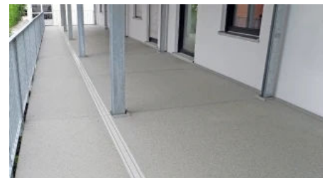
Detail mittlere Entwässerungsrinne
