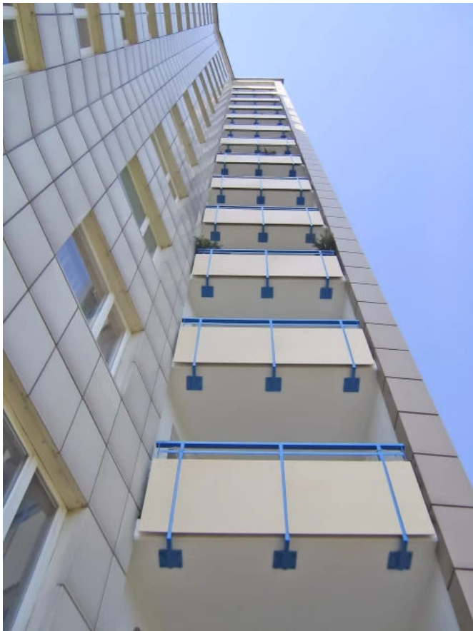
BALKOTOP® Holzzement Geländer- und Fassadenplatten aus Faserzement
