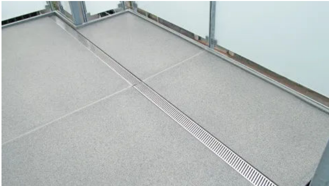
Detail Bakodur® E Holzzement-Gefälleplatten mit Ablaufrinne
