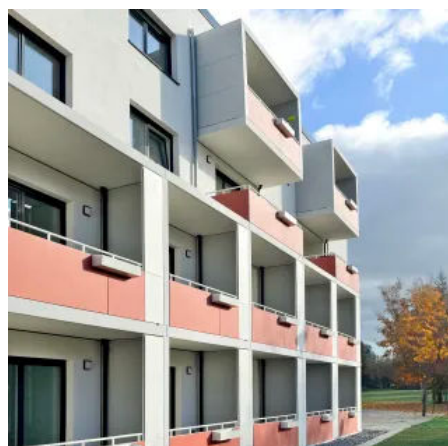
BALKOTOP® Faserzement Balkon-Geländerplatten
