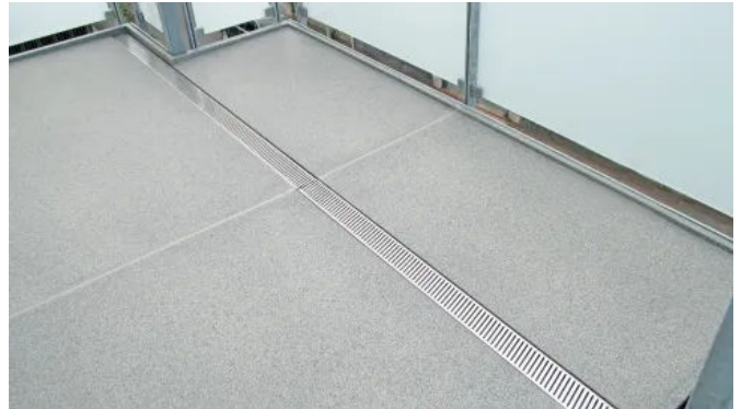
Detail Bakodur® E Holzzement-Gefälleplatten mit Ablaufrinne
