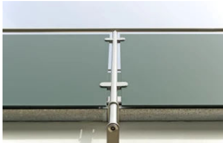
BALKOTOP® Faserzement Geländer- und Fassadenplatte
