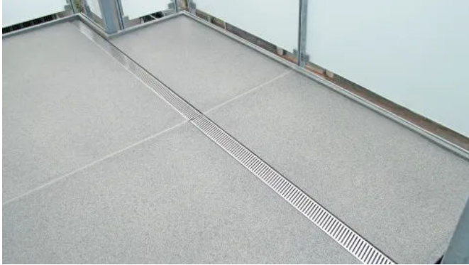
Detail Bakodur® E Holzzement-Gefälleplatten mit Ablaufrinne
