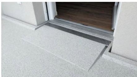
Detail barrierefreie Ausführung
