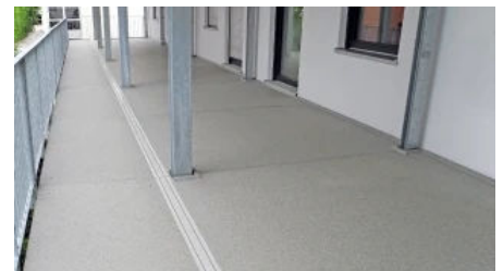
Detail mittlere Entwässerungsrinne
