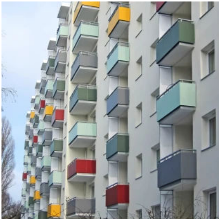
BALKOTOP® Faserzement Balkon-Geländerplatten
