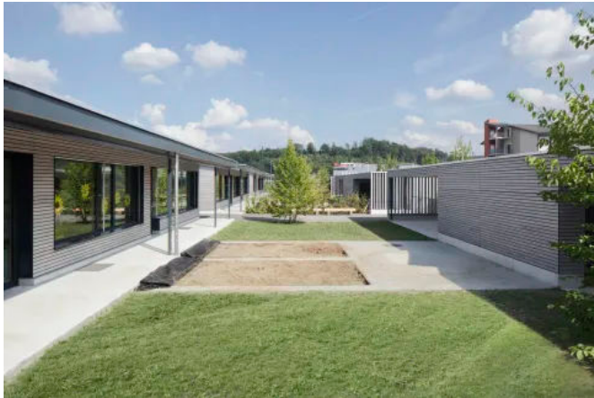
Erweiterung Schulanlage Oberfeld, Oftringen
