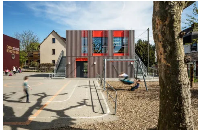
Modularer Holzbau für temporäre / definitive Schulen, Frankfurt
