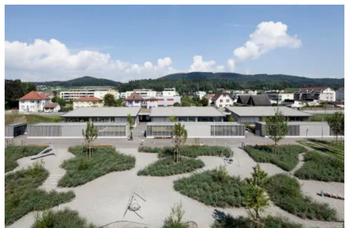
Erweiterung Schulanlage Oberfeld, Oftringen
