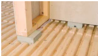
Druckfeste Unterleger für Zwischenwände I (© Nicole Aigner Videografie)
