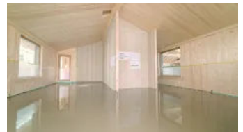
Planebene Druckzonen zur Aufnahme von Installationsebene bzw. Estrichaufbau I (© Nicole Aigner Videografie)
