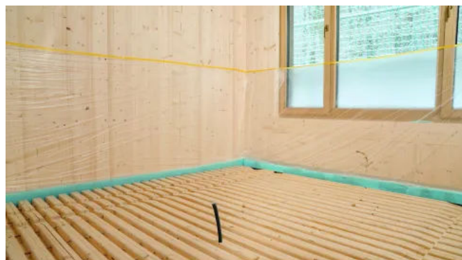
Deckenkonstruktion aus Massivholzfertigteilen I (© Nicole Aigner Videografie)
