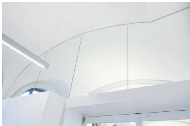
Brandschutzverglasung mit rahmenlosem Wand-/Deckenanschluss
