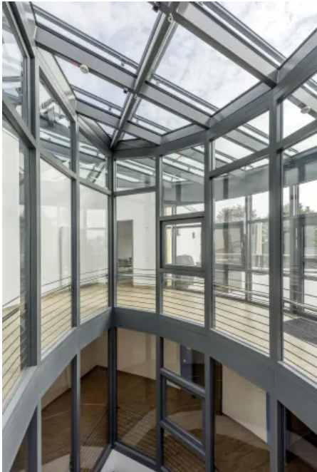
Brandschutzverglasung F30 mit absturzsichernder Funktion nach TRAV
