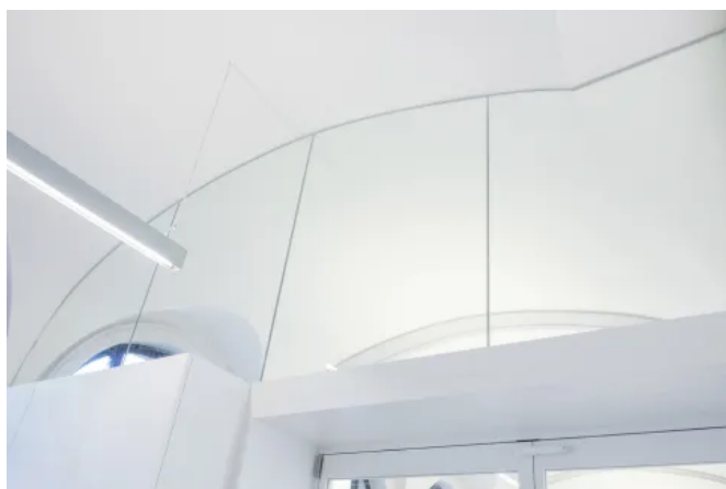
Brandschutzverglasung mit rahmenlosem Wand-/Deckenanschluss
