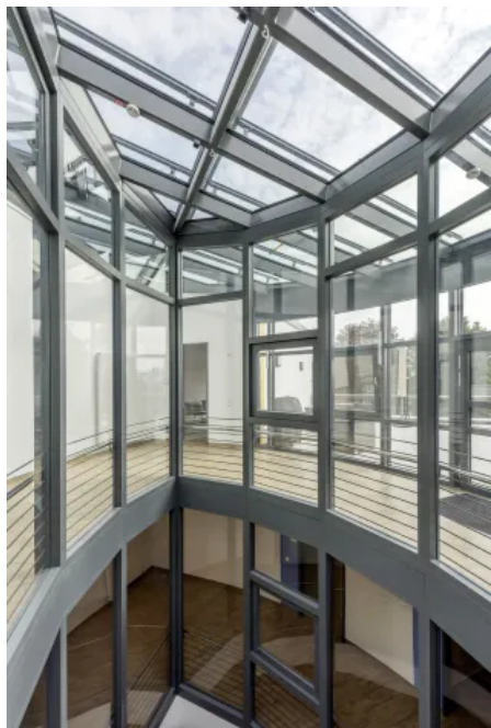
Brandschutzverglasung F30 mit absturzsichernder Funktion nach TRAV
