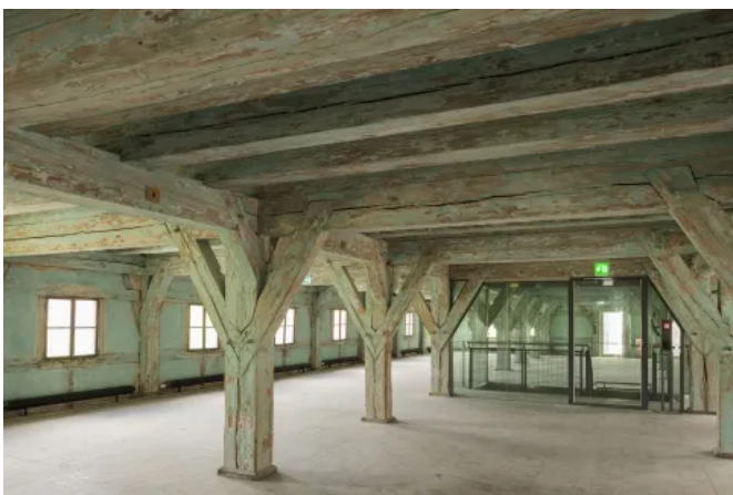
Treppeneinhausung mit Brandschutzverglasung F30/T30
