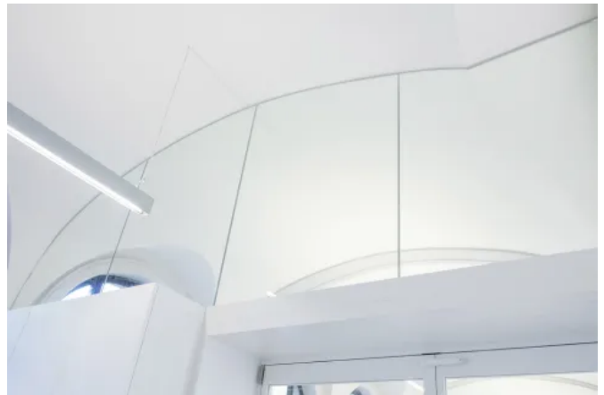
Brandschutzverglasung mit rahmenlosem Wand-/Deckenanschluss
