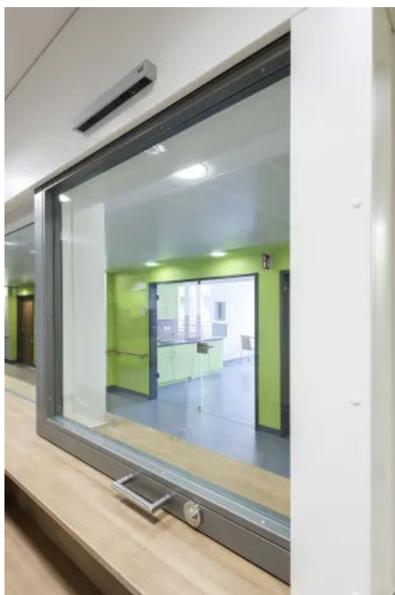
Detail Schiebefenster F30
