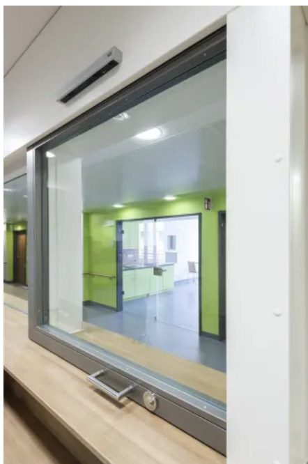
Detail Schiebefenster F30
