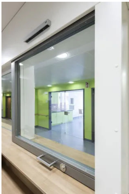
Detail Schiebefenster F30
