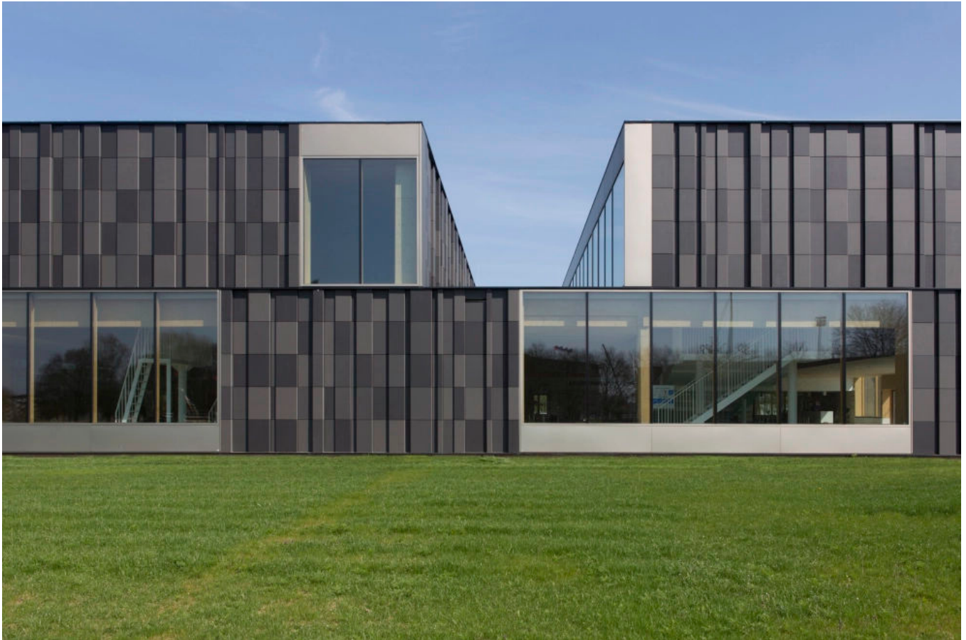
Geusseltbad Maastricht – ästhetische Fassadengestaltung mit unsichtbarer Befestigung und großformatigen Mosa Keramikplatten.
