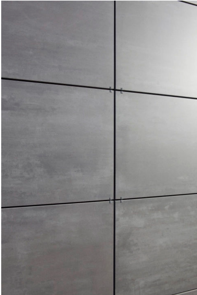
Slegers Budel – großformatige Mosa Fassadenplatten mit sichtbarer Klammerbefestigung und ausdrucksstarker Oberfläche.
