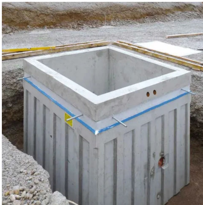
HIEBER Pumpensumpfschacht Typ SA mit sichtbarer Anschlussbewehrung
