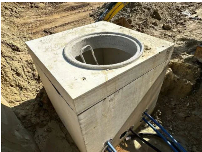
Ausführungsbeispiel HIEBER Kabelzugschacht mit Installationen
