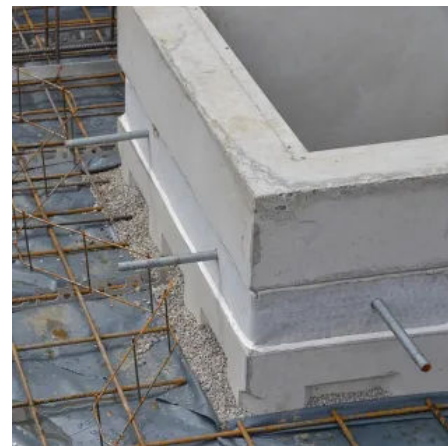
Anschlussbewehrung beim Pumpensumpfschacht Typ SA
