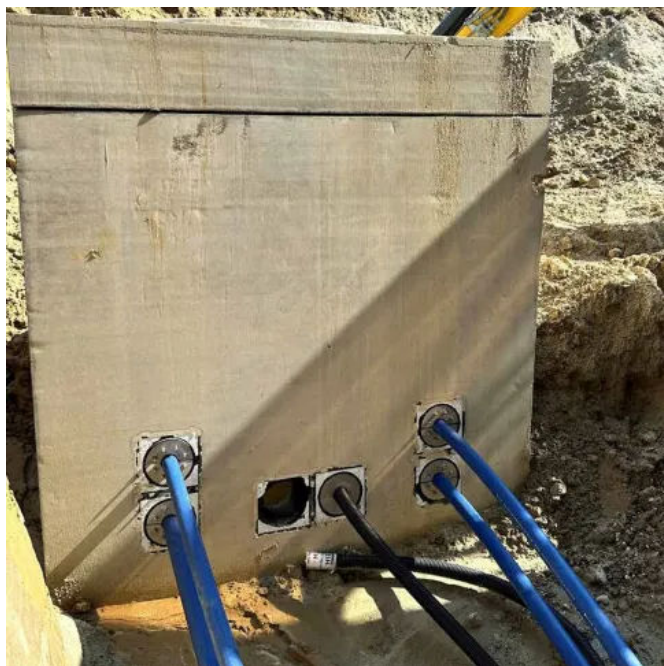
Einsatz der Fertigfundamente im Solarpark Wörlschwang
