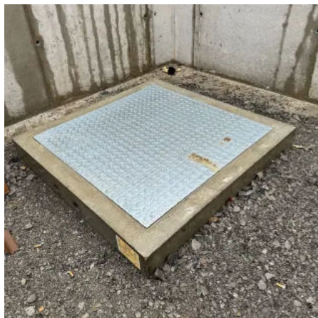
Anwendungsbeispiel Pumpensumpfschacht Typ SA mit Riffelblechabdeckung
