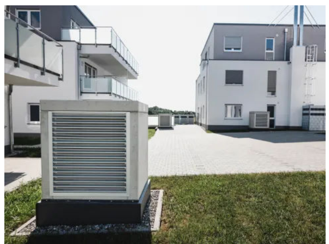
Lüftungsschachteinhausung in Sichtbetonqualität
