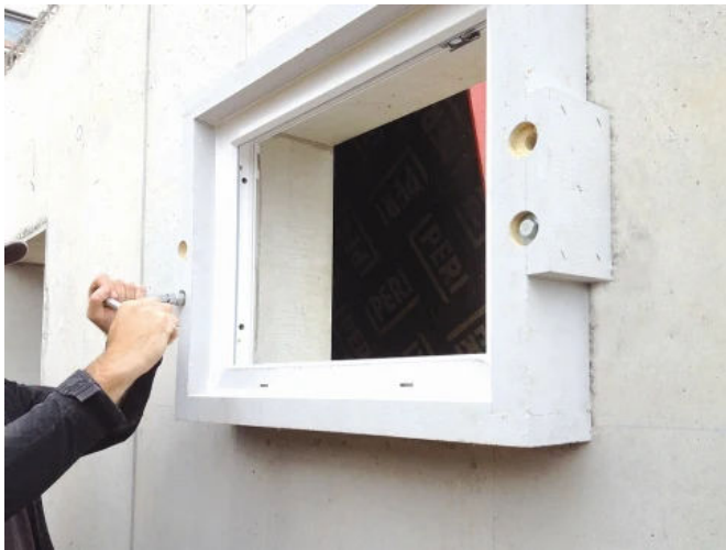
Kellerfenster-System CombiTherm - Baustelle
