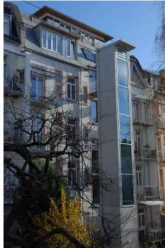
Wohnhaus mit Aufzug in Frankfurt
