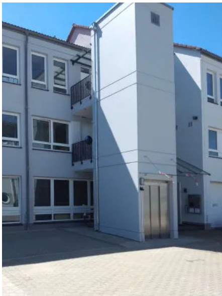
Aufzugsschacht an Verwaltungsgebäude in Friedberg
