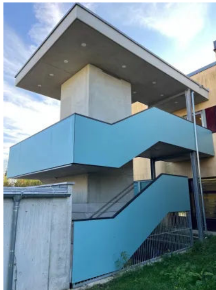
Kombination Aufzugsschacht mit Treppenaufgang in Fürstenfeldbruck
