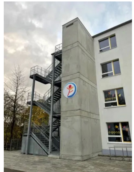
Aufzugsschacht an einer integrativen Schule in Lauingen
