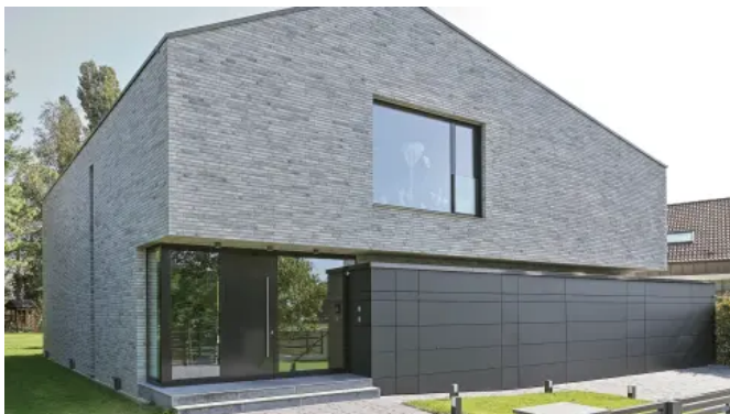
Einfamilienhaus mit heroal D 92 UD Haustürsystem
