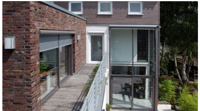
Wohnhaus mit Dachterrasse
