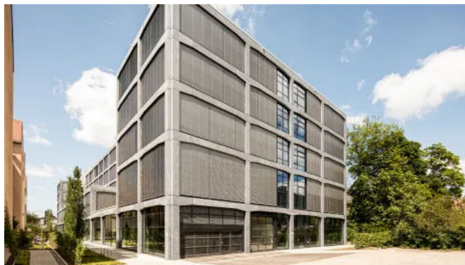
Jalousien und Raffstoren werden fertig im Kasten vormontiert
