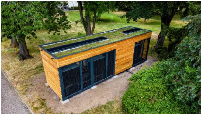
Die fertige Heizungszentrale aus einer Hand
