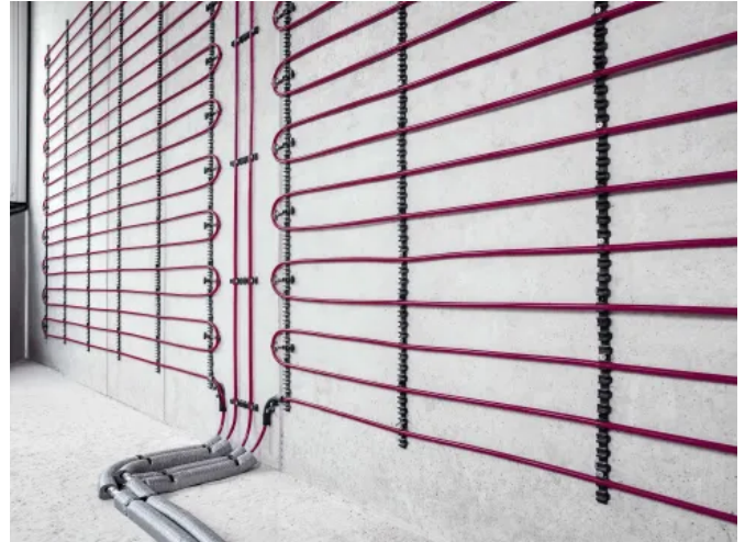
Durch die Rohrklemmschienen werden die Rohre sicher fixiert und die Verlegeabstände normgerecht eingehalten.
