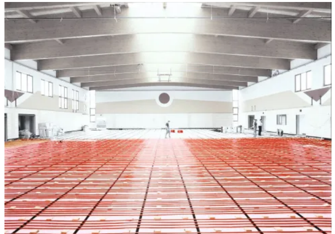
REHAU Schwingbodenheizungen schaffen ein energieeffizientes, gleichmäßiges Hallentemperaturprofil ohne Wärmestau unter dem Hallendach.
