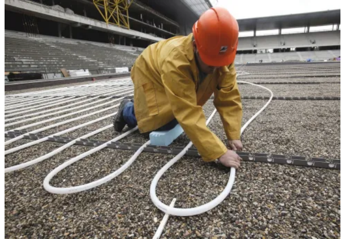
REHAU Rasenheizungen werden Just-in-Time geliefert und sind schnell und einfach zu montieren.
