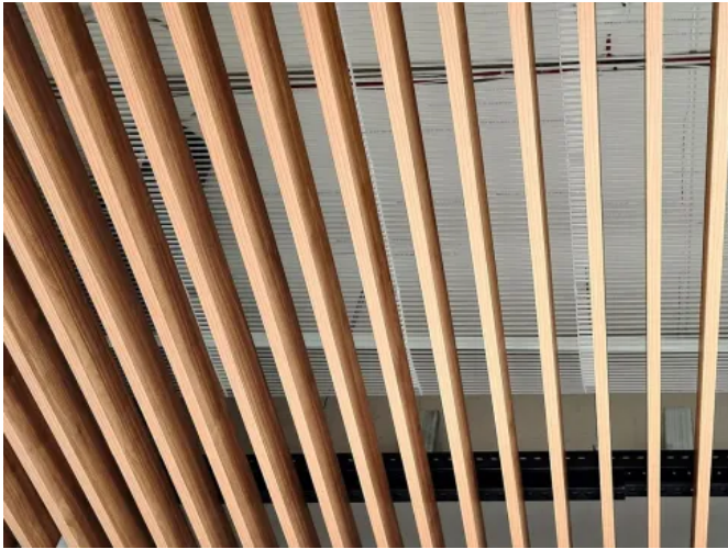
Offene Deckenkonstruktion mit Holzlamellen
