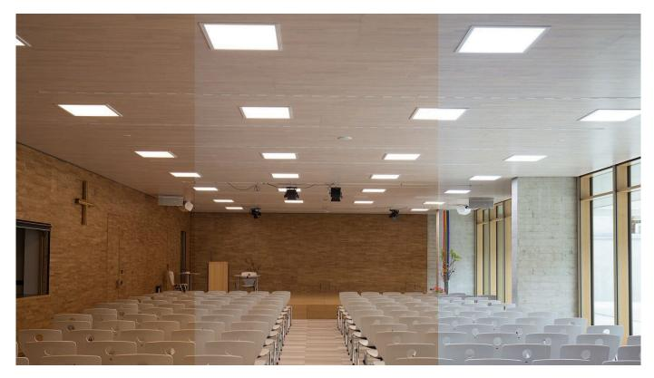
Bei der biologisch wirksamen Beleuchtungsanlage werden die voreingestellten Farbwerte genutzt, um die Lichtfarbe der angeschlossenen Leuchten so zu regeln, dass der Weißton im Raum dem zu dem Zeitpunkt optimalen Weißton des Tageslichts möglichst genau entspricht und sich optimal auf den Biorhythmus des Menschen auswirkt.
