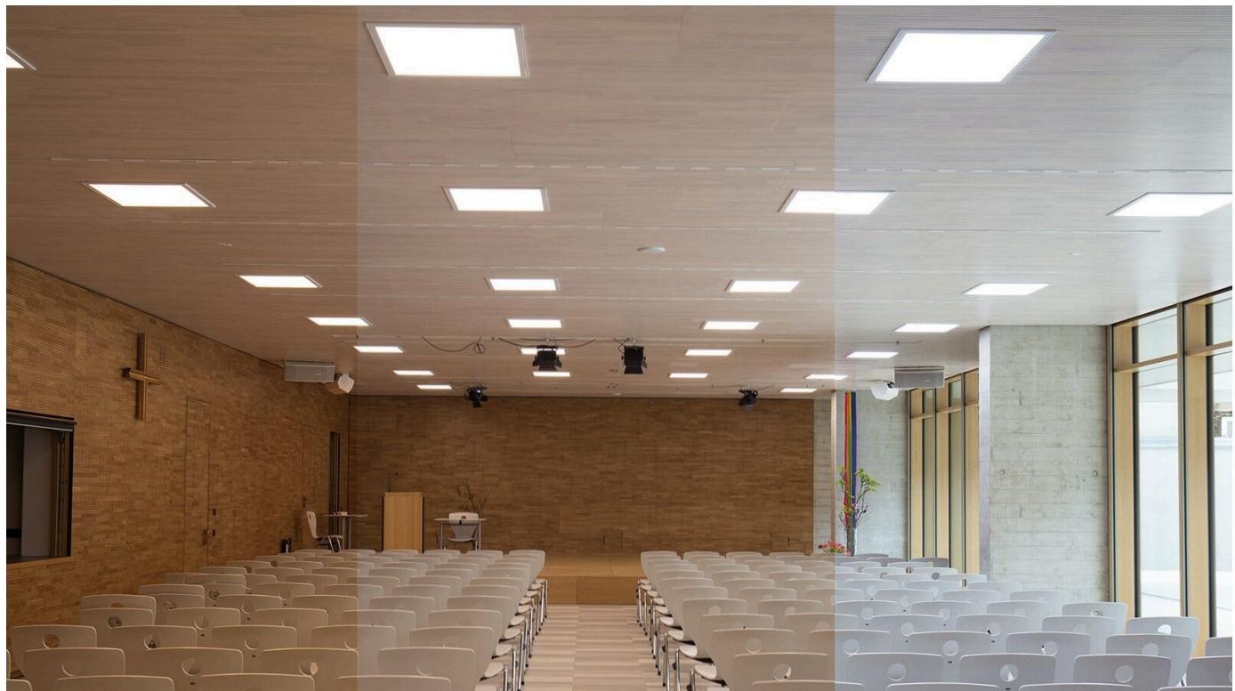
Bei der biologisch wirksamen Beleuchtungsanlage werden die voreingestellten Farbwerte genutzt, um die Lichtfarbe der angeschlossenen Leuchten so zu regeln, dass der Weißton im Raum dem zu dem Zeitpunkt optimalen Weißton des Tageslichts möglichst genau entspricht und sich optimal auf den Biorhythmus des Menschen auswirkt.
