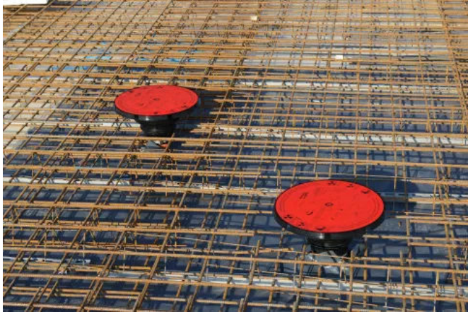
Durch den Einsatz des Anschlussstrichters werden aufwändige Nacharbeiten bei der Betonierung, wie rechteckige Aussparungen, vermieden.
