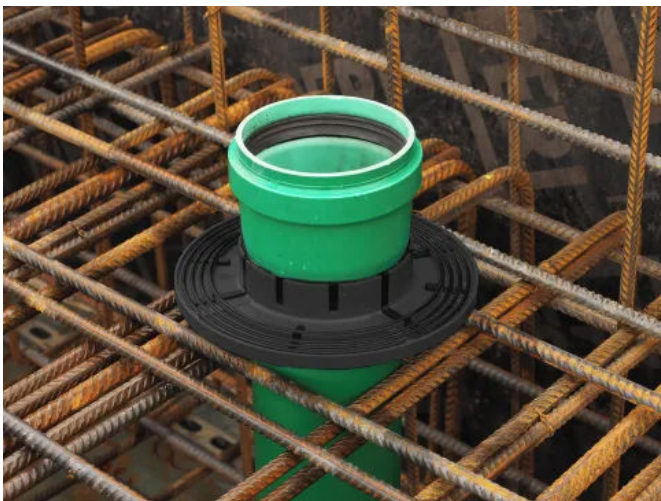
Mauerkragen KG-FIX vor dem Betonieren der Bodenplatte
