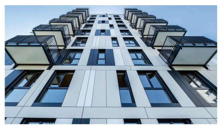
Faserzementtafeln nach DIN EN 12467 für den Einsatz als vorgehängte hinterlüftete Fassade.
