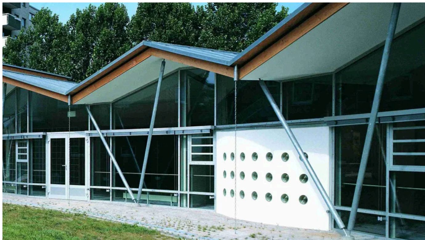
Kindertagesstätte, Frankfurt am Main | Architekt Toyo Ito
