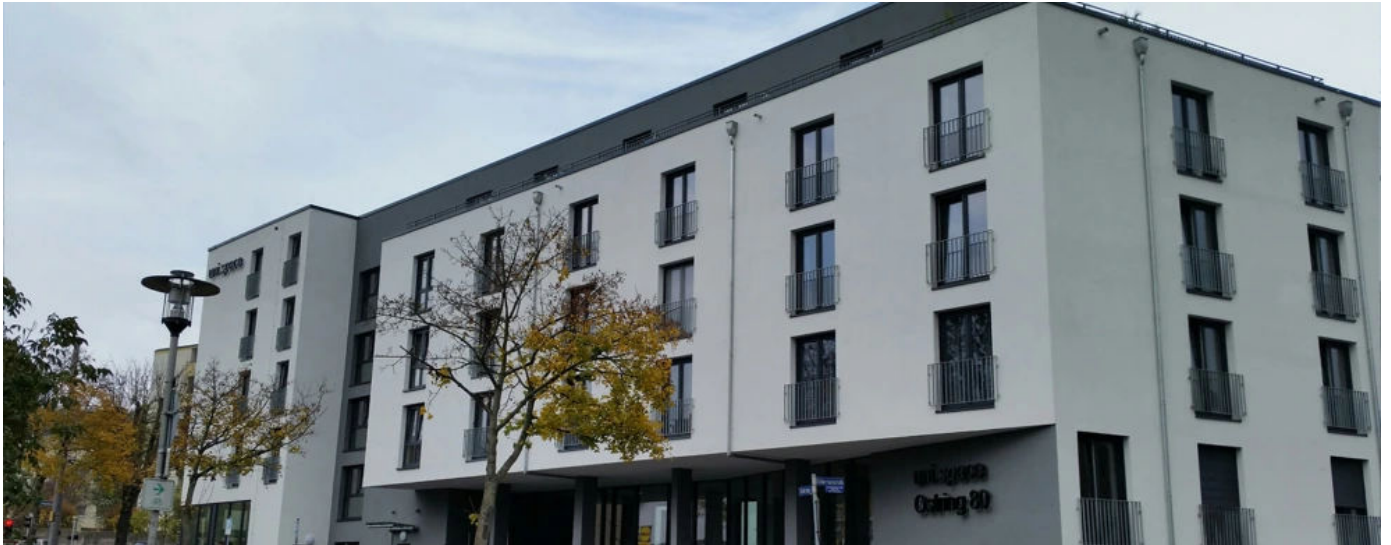
Ihringshäuser Straße in Kassel, 2017
