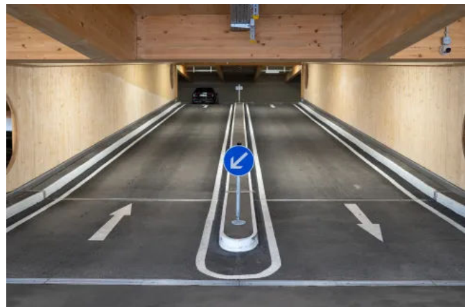
Die Parkflächenabdichtung aus Gussasphalt in Holzparkhäusern unterstützt eine nachhaltige Bauweise.
