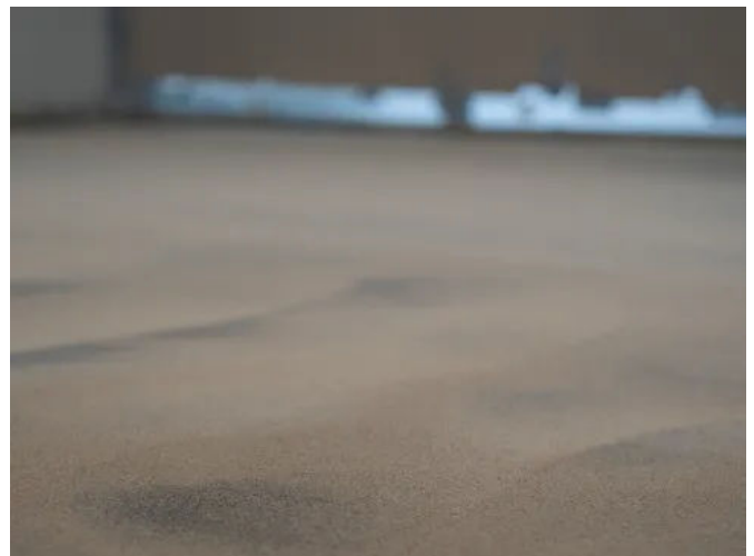
Gussasphaltestrich kann auf großen Flächen fugenlos eingebaut werden. Der Estrich ist widerstandsfähig, trittschalldämmend und schnell belegreif.
