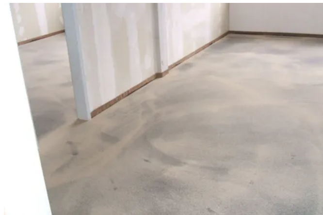
Gussasphalt vereint eine unmittelbare Nutzbarkeit und geringe Aufbauhöhe. Der Einbau erfolgt wasserfrei - ohne zusätzliche Baufeuchte.
