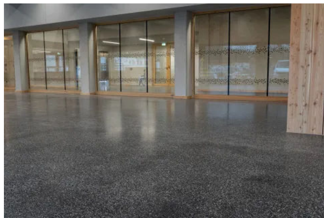
TERRAZZO im Gymnasium Langenhagen
