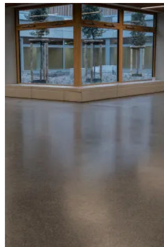
TERRAZZO im Gymnasium Langenhagen
