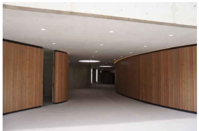
Gussasphaltestrich kann auf großen Flächen fugenlos eingebaut werden. Der Estrich ist widerstandsfähig, trittschalldämmend und schnell belegreif.
